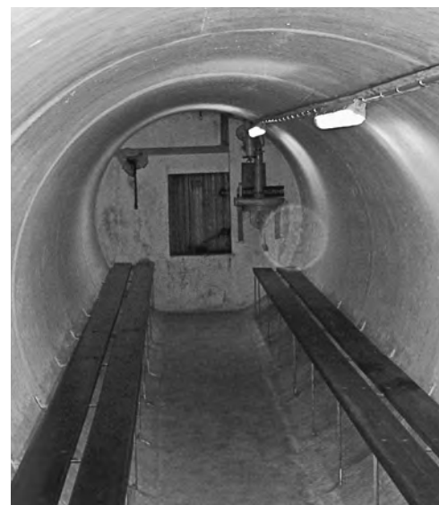
Rørdækningsgrav under Holmens Sixtusbatteri. Foto: Morten Stenak 2011.
