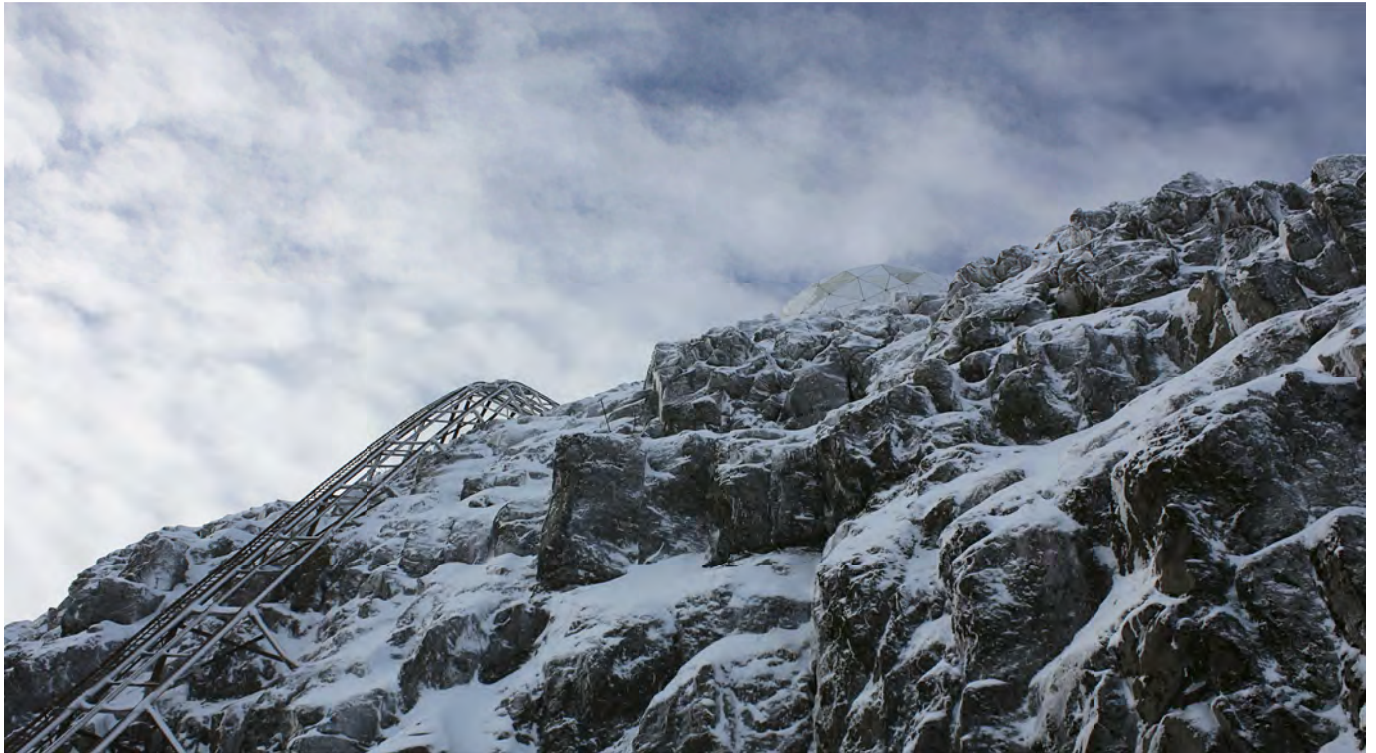
Udsigten fra fjeldvejen ved tunnellen ind til bunkeren. Til venstre ses liften, der gik ca. 50 m ned, næsten lodret, og blev brugt til at transportere tungt og stort gods mellem fjeldvejen og toppen af fjel- det. Midt i billedet skimtes den større radome, hvor radaren var. Foto: Sámæl T.F. Johansen 2013.
