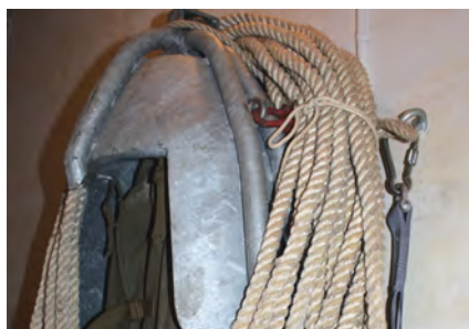
17. Hovedindsugningsskakt med en "raket", der kan bringe sårede til jordoverfladen. Foto: Karsten Pedersen.
