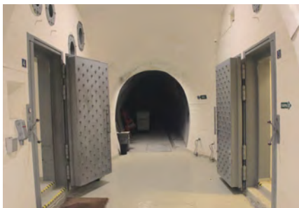
10. Knudepunkt med 2½ tons tunge betonarmerede stældøre, der er bygget til at kunne tåle trykbølgen fra en atomeksplosion. Foto: Karsten Pedersen.
